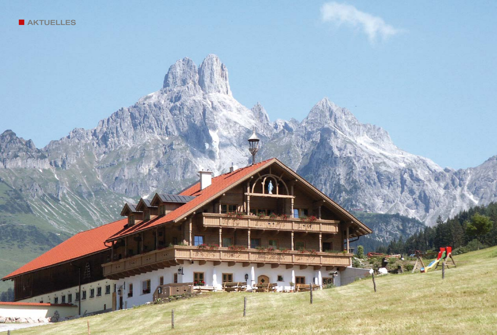
Dieser stattliche Holzbauernhof bekam eine neue Fassade, neue Balkone und einen komplett revitalisierten Innenausbau. Nachträglich wurde noch eine Remise in Massivholzbauweise angebaut.
